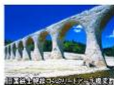
旧国鉄士幌線コンクリートアーチ橋梁群
