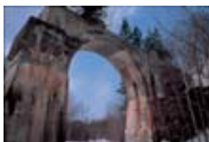
添島 均 本別町 旧国鉄士幌線コンクリートアーチ橋梁群
