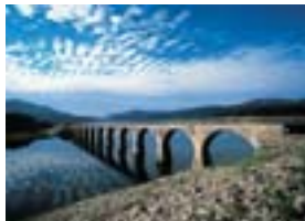
瀧 伍一 帯広市 旧国鉄士幌線コンクリートアーチ橋梁群
