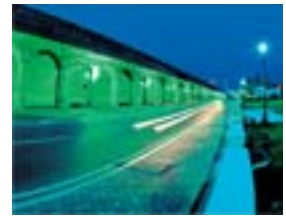
大橋 英児 稚内市 稚内港北防波堤ドーム
