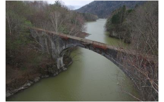
第3音更川橋梁
