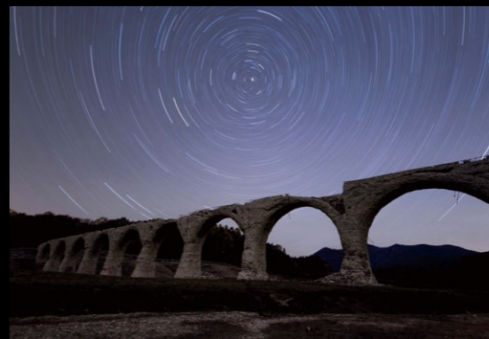
悠久なる [撮影/タウシュベツ川橋梁 2020年10月]
